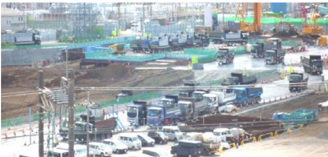
土砂を運ぶトラックがふえている駅工事ヤード 4/28
