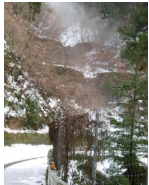
県が整備した東南林道の砂防堰堤
