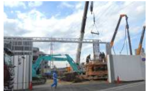
16 号交差点トンネル、工事の様子
