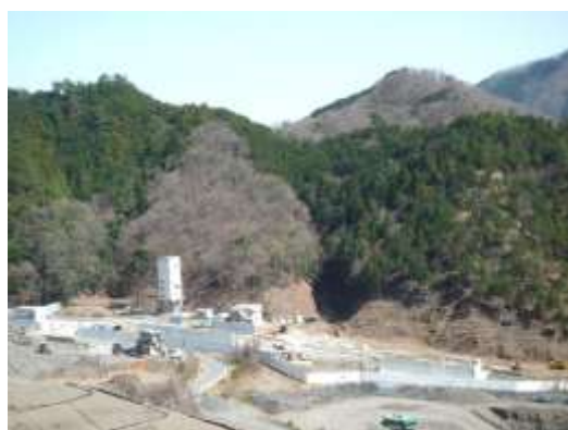
大洞非常口工事ヤード（造成中）
