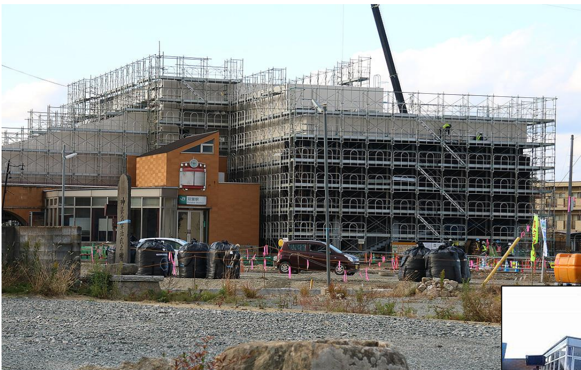
建設中の双葉駅。まだ周辺にはフレコンパックが見られる。(2019.11.16)
