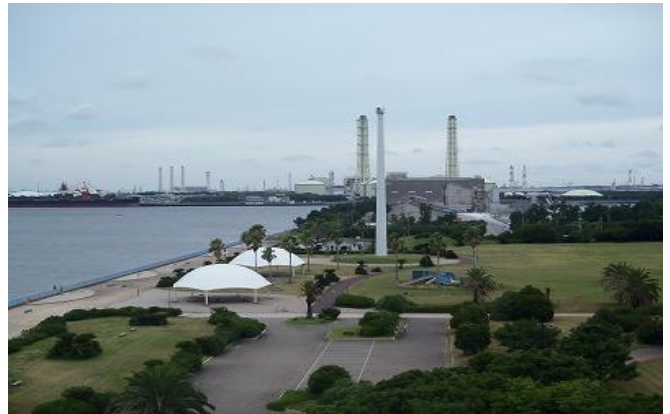
東京湾千葉の臨海部に林立する火力発電所
