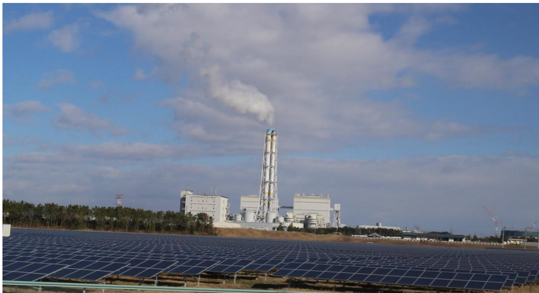
東京電力広野火力発電所
