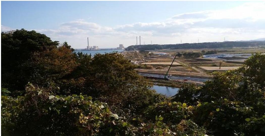
天神崎スポーツ公園の展望台から広野火力発電所を臨む
